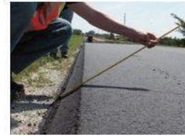
Roadway Safety Edge
